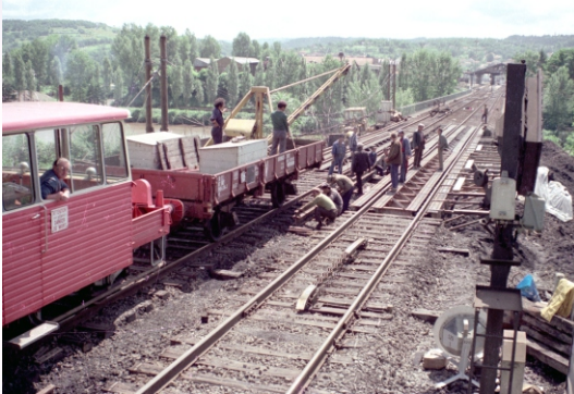
Photo : J.M.STEINER Opération de maintenance d'ouvrage d'art avec wagon plat OCEM.
