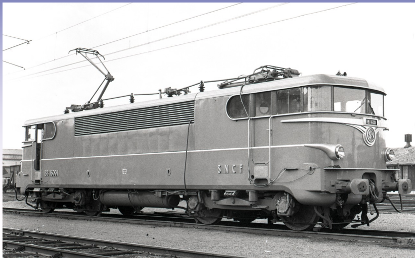
Photo : La BB-16001 neuve au cours des ses premiers essais - Coll. J.M. Steiner
